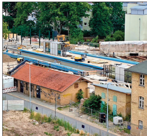
Baustelle S-Bahnhof Lichtenrade mit den eingebobenen Brückenelementen.
