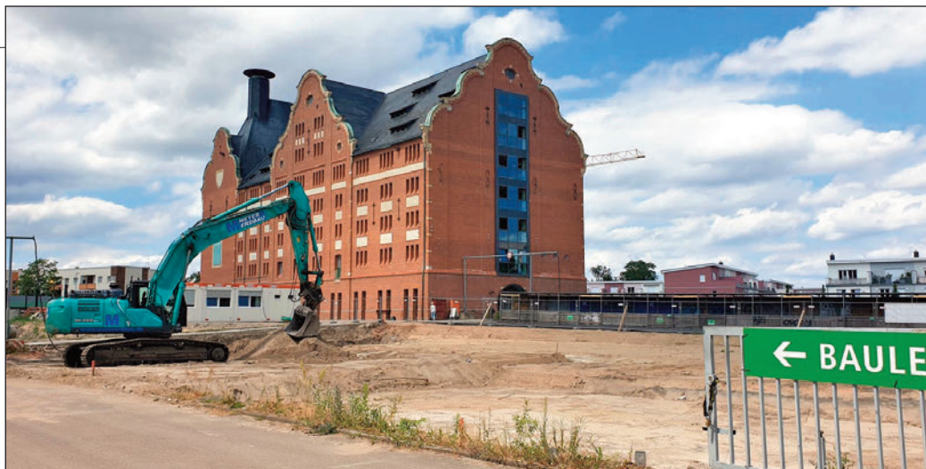
Bauabschnitt vor der Mälzerei an der Steinstraße. Hier wird bereits fleißig gearbeitet für das neue Quartier.
