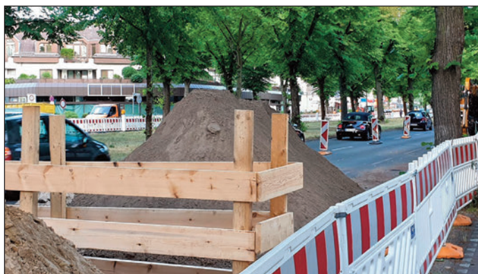
Sichtungsschacht der Abwasserrohre
