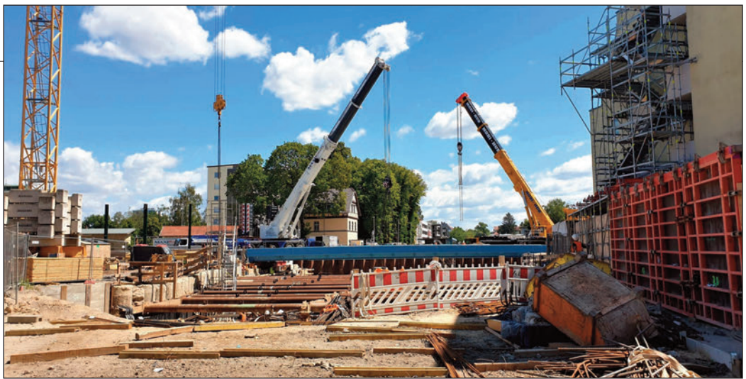
1. Brückenelement kurz nach dem Einhub durch die beiden 450-Tonnen-Kräne aus Sicht der Bahnhofstraße.
