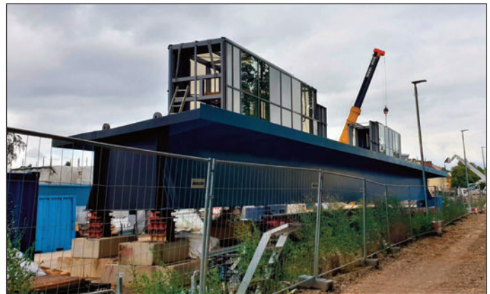
Bahngleiselement mit Wartehäuschen vor dem Einbau. Fotos: Heimann
