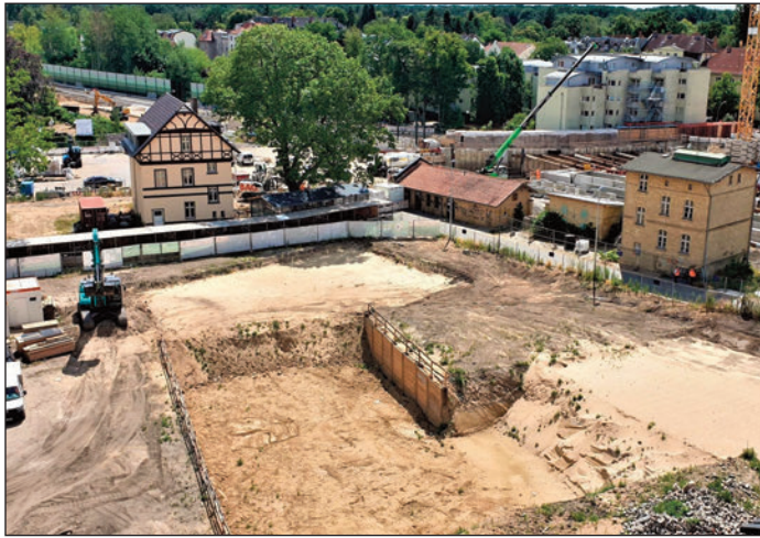
Bauabschnitt zum S-Bahnhof Lichtenrade.
