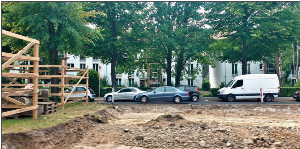
Baustelle der Wasserbetriebe auf dem Mittelstreifen stadtauswärts kurz hinter der Grimmstraße.
